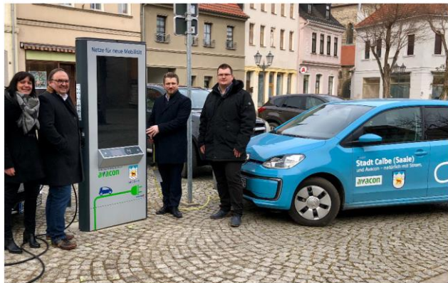
Calbes Bürgermeister Sven Hause (2.v.r.) sowie die Avacon-Vertreter Thomas Braumann (2.v.l.), David Ilgenstein und Anett Johanson während der offiziellen Inbetriebnahme der Innovationen E-Säule auf dem Marktplatz.
