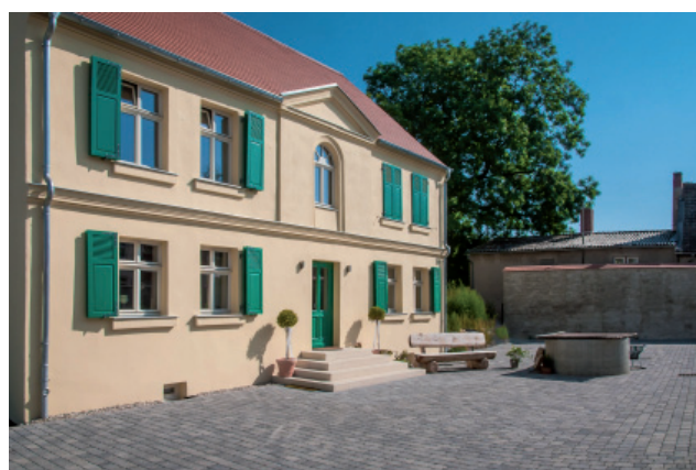
Abb.13 Sanierte Hofanlage Westeregeln; Fotograf: C. Hertel
