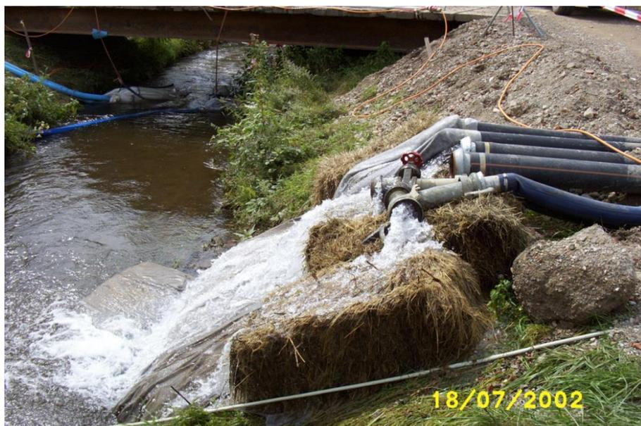
**Abbildung 17: Einleitung des geförderten Grundwassers in einen Vorfluter**
