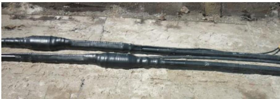
Abbildung 7: Fertige Muffen vor dem Verfüllen mit Bettungsmaterial
