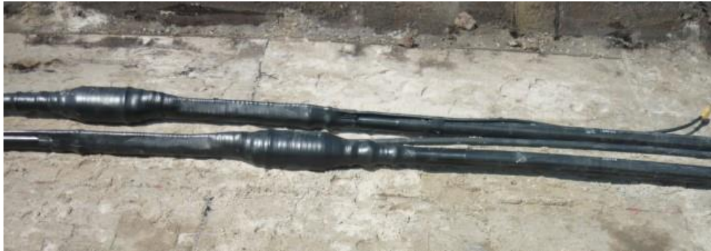
Abbildung 10: Fertige Muffen vor dem Verfüllen mit Bettungsmaterial
