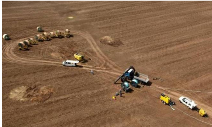
Abbildung 36: Trommel- und Windenplatz für Seilzug (Quelle: 50Hertz)
