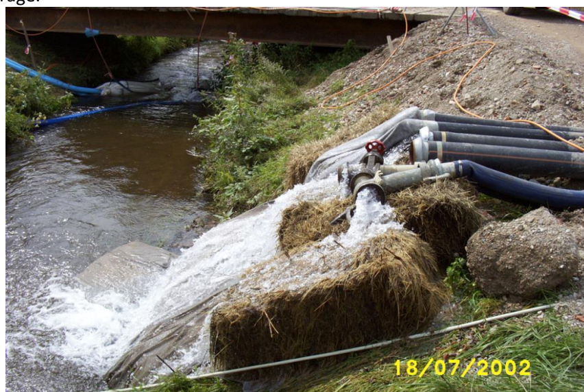
Abbildung 29: Einleitung des geförderten Grundwassers in einen Vorfluter
