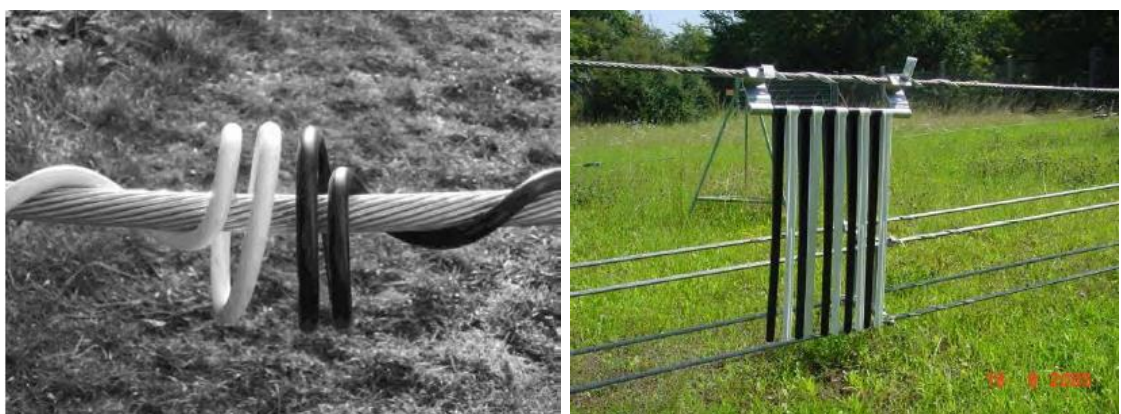
Abbildung 22: Beispiele für Vogelschutzmarker (links: Spiralmarker; rechts: Klappenmarker)
